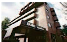
サンメンバーズ京都嵯峨 京都府京都市右京区 嵯峨広沢南野町27-1
